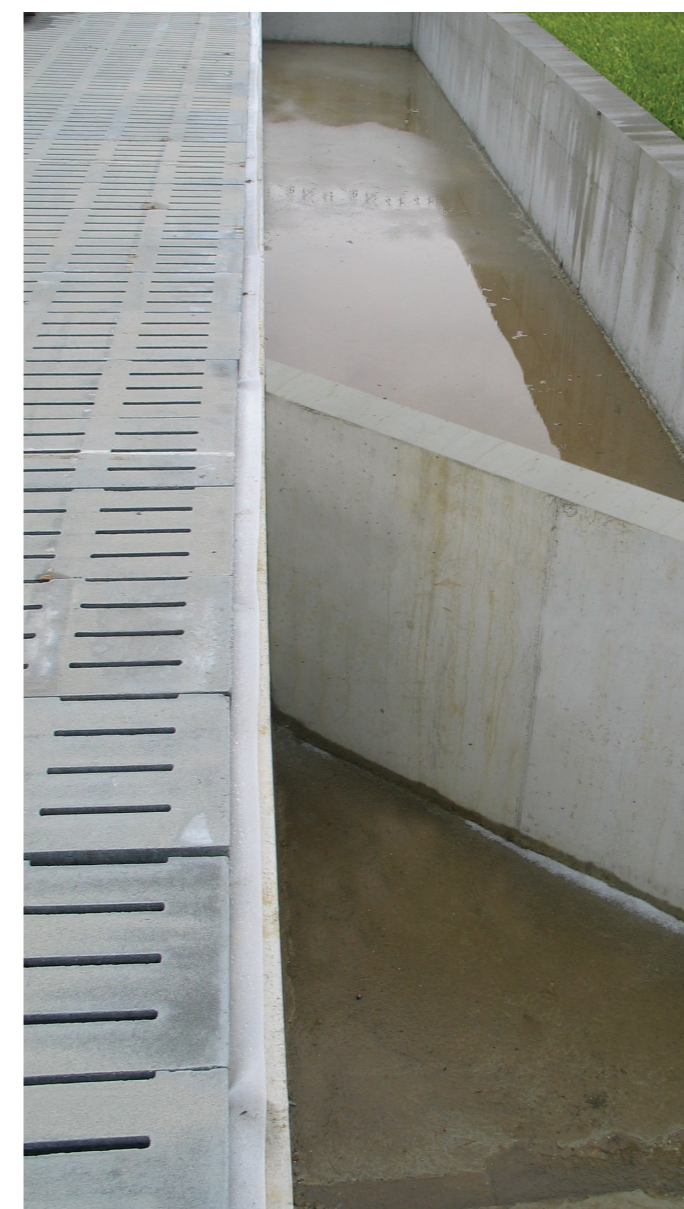
Prilagođava se svakoj građevinskoj tehnologiji.
