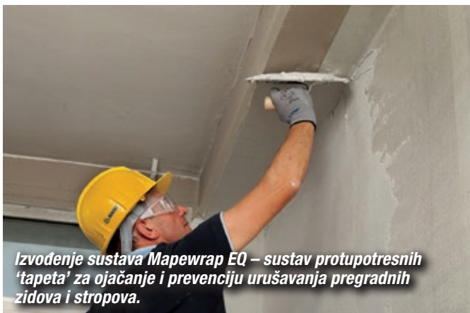
Izvođenja sustava Mapewrap EQ – sustav protupotresnih „tapeta“ za ojačanje i prevenciju urušavanja pregradnih zidova i stropova.
