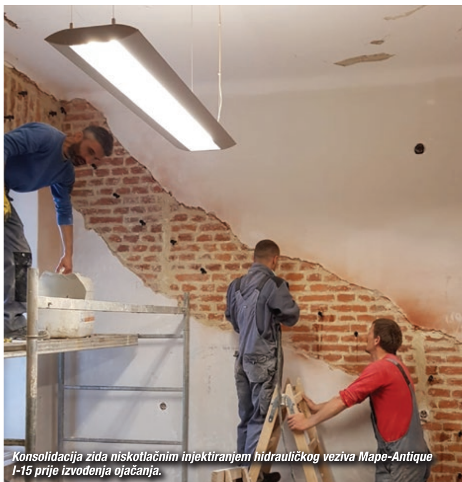
Radovi na sanaciji zgrade u Preradovićevoj ulici.
